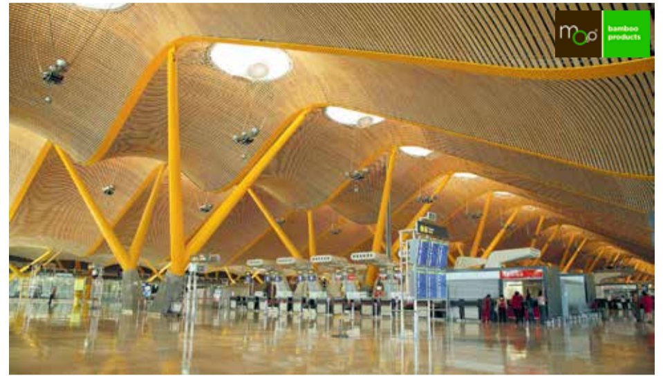
Het grootste bamboeproject ter wereld, 200.000m2 plafonddelen in het vliegveld van Madrid, geleverd door MOSO.
